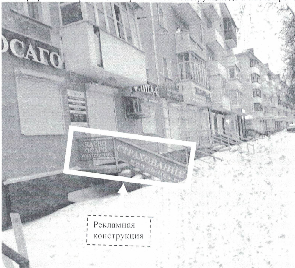
Фото №1: пр.Циолковского д.12/26 – до проведения работ по демонтажу.
