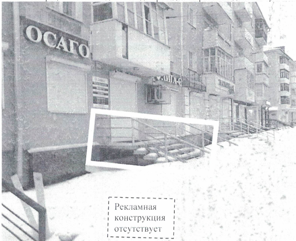
Фото №2: пр.Циолковского д.12/26 – после проведения работ по демонтажу.
