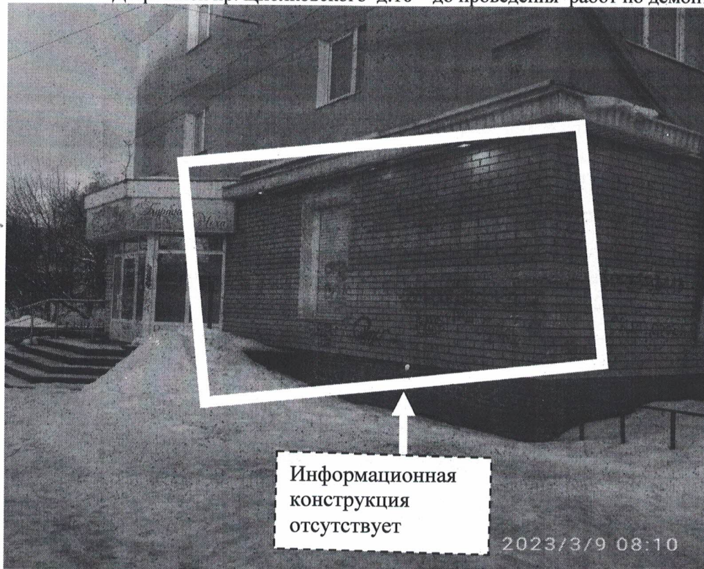
Фото №2: г.Дзержинск пр. Циолковского д.16 – после проведения работ по демонтажу.
