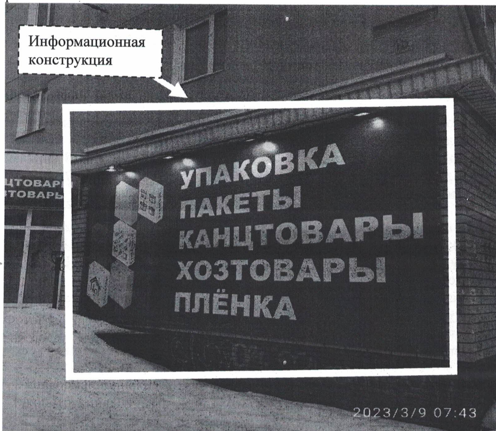
Фото №1: г.Дзержинск пр. Циолковского д.16 – до проведения работ по демонтажу.
