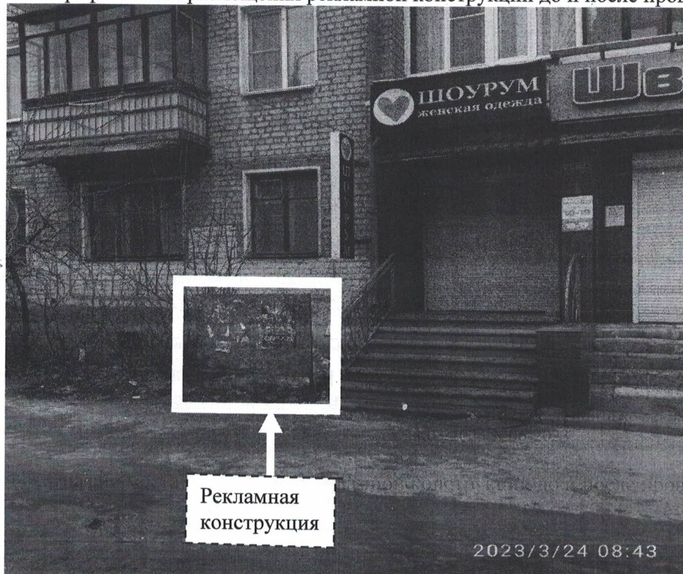
Фото №1: пр.Циолковского в районе д.26 – до проведения работ по демонтажу.
